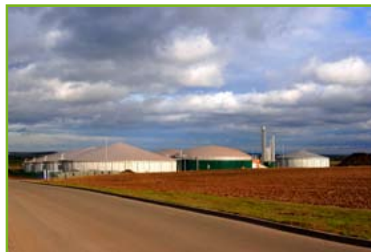
Biomethane plant in Könnern
